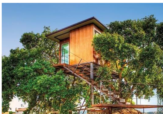
Figura 6. Casas da árvore, Encostas do Côa
