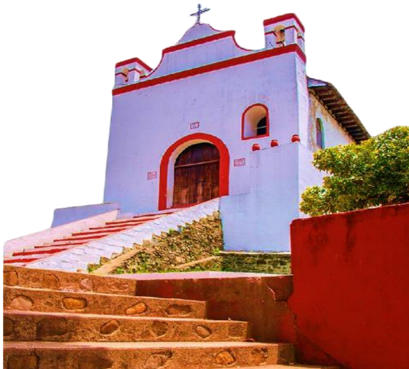
Figura 1. Iglesia Santiago Apóstol
