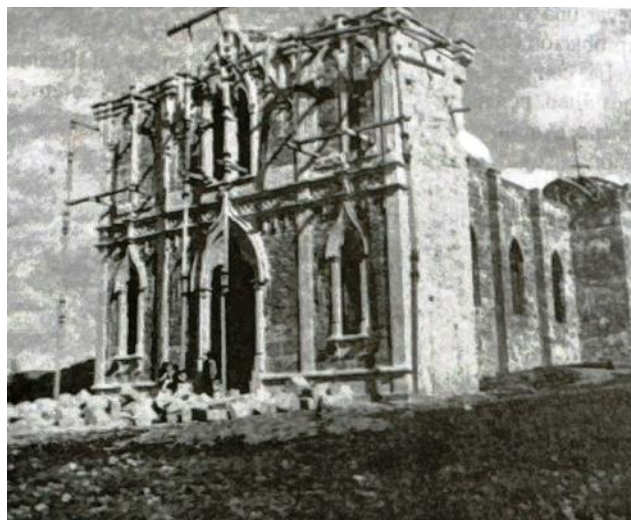
Figura 12. Proceso de construcción del santuario, con los andamios y trabajando la cantera
