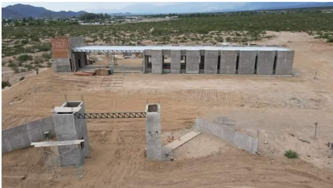
Figura 6. Centro de Interpretación de Las Tamberías del Inca en construcción
