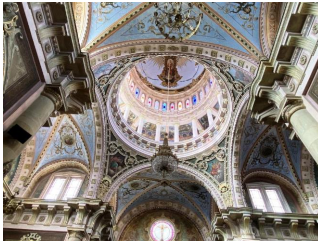
Figura 6. Vista de la cúpula desde el crucero.
