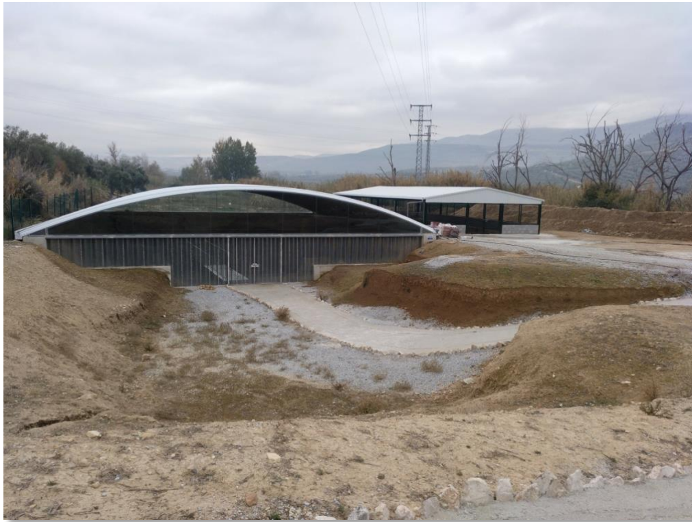
Figura 4. Cubiertas protectoras de las zonas excavadas
